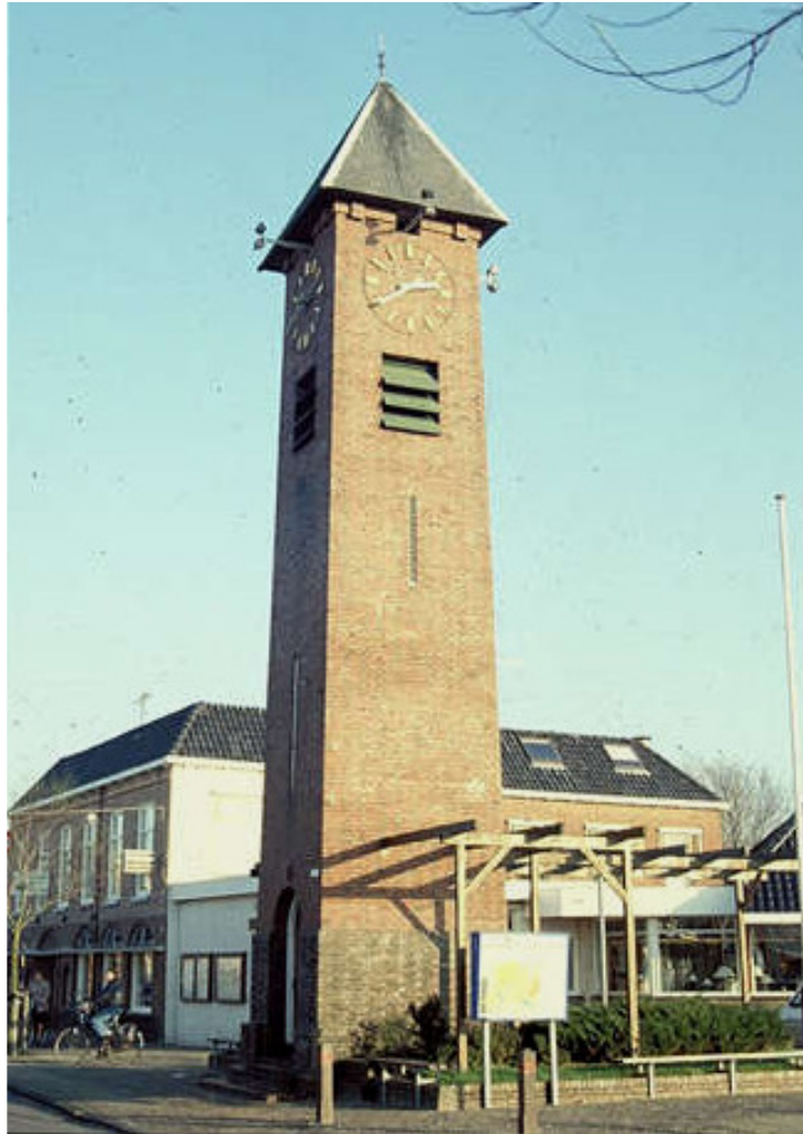
De klokkentoren op het Torenplein
