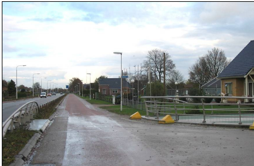
De Betonwei met parallelweg vanaf de kruising met De Bosk in noordelijke richting
