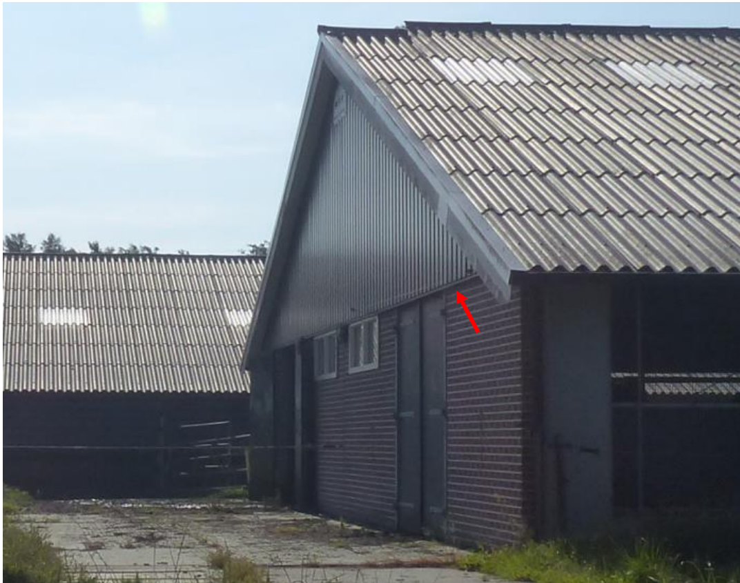
Foto 4 De metalen beplating aan de achterkant van de stal biedt door de extra plaat achter de metalen plaat geen geschikte invliegopeningen voor vleermuizen.
