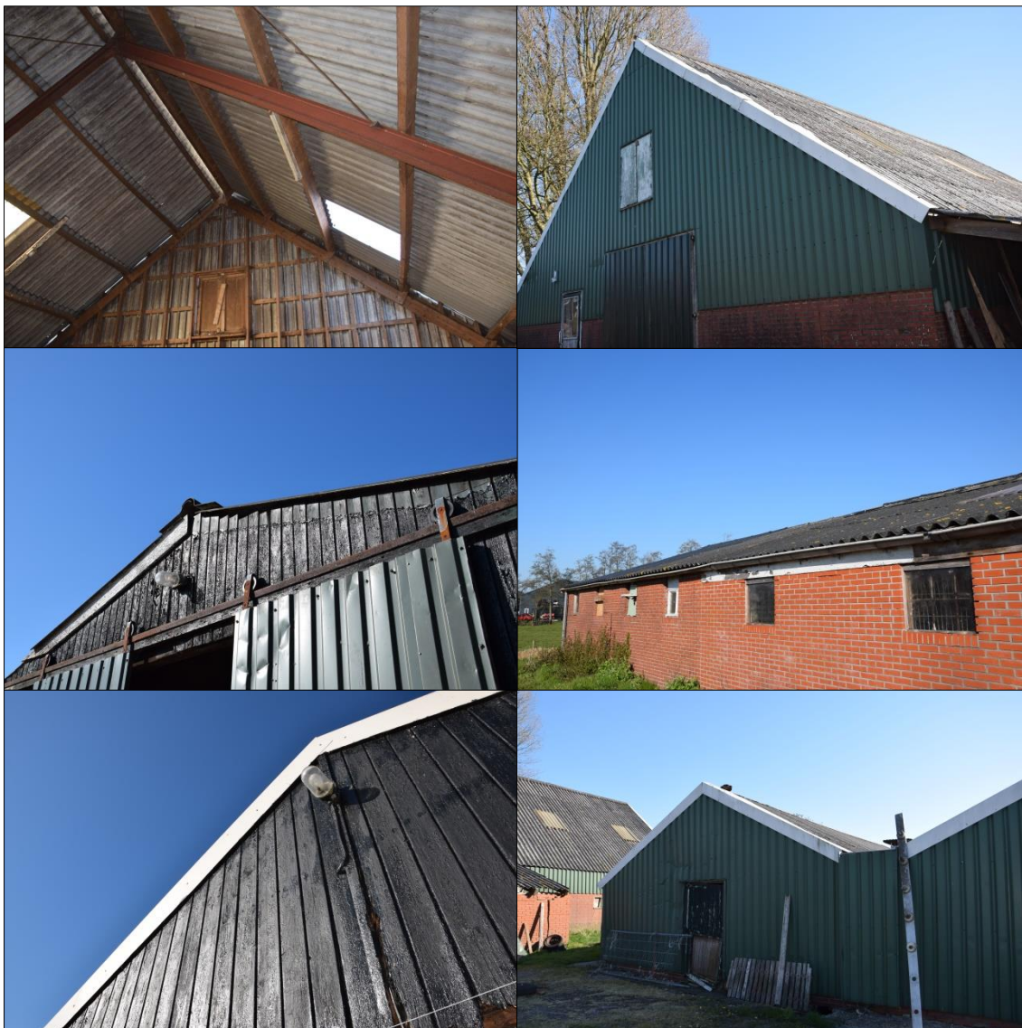
Foto's 3 en 4. Linksboven de binnenzijde van schuur 3. Rechtsboven de buitenzijde van schuur 3. Links midden de gevel van schuur 2. Rechts midden de buitenzijde van schuur 2. Linksonder de gevel van de zuidelijke schuur (4). Rechtsonder één van de zuidelijke schuren (4).
