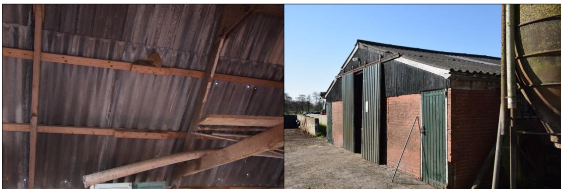
Foto's 1 en 2. Impressie van het terrein op 28 april 2021. Links de binnenzijde van het dak van schuur 1. Rechts schuur 2 gezien vanuit het noorden.
