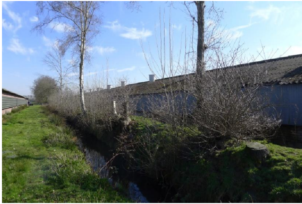
Foto 2 De dykswal met een aantal bomen, houtopslag en sloot.
