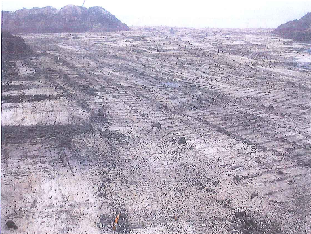
Figuur 5: It Heechsân, uitbreiding zandwinning. Een deel van de zuidelijke helft van het plangebied gezien in oostelijke richting (in de richting van de zandwinningsplas). De bodem is hier zoveel mogelijk afgegraven tot op het schone gele zand van de C-horizont.
