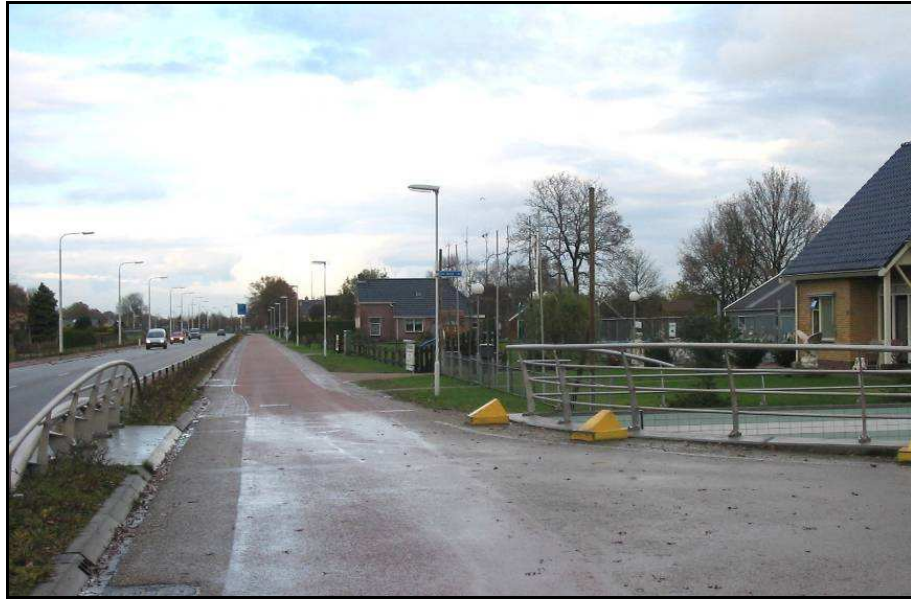
Figuur 1. De Betonwei met parallelweg vanaf de kruising met De Bosk in noordelijke richting
