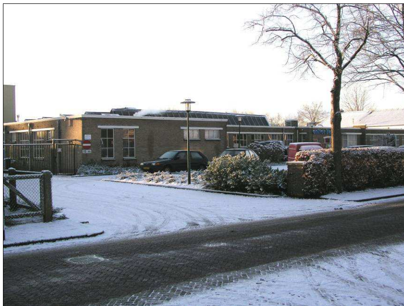
Figuur 4. Een deel van de bedrijfsgebouwen van Enitor
